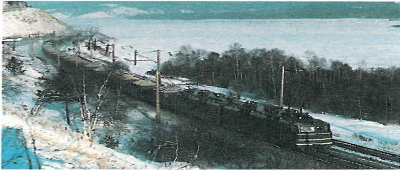
Строительство Байкало-Амурской магистрали (БАМ) (1974-1984) с началом активного освоения Сибири со второй половины 1950-х годов.
